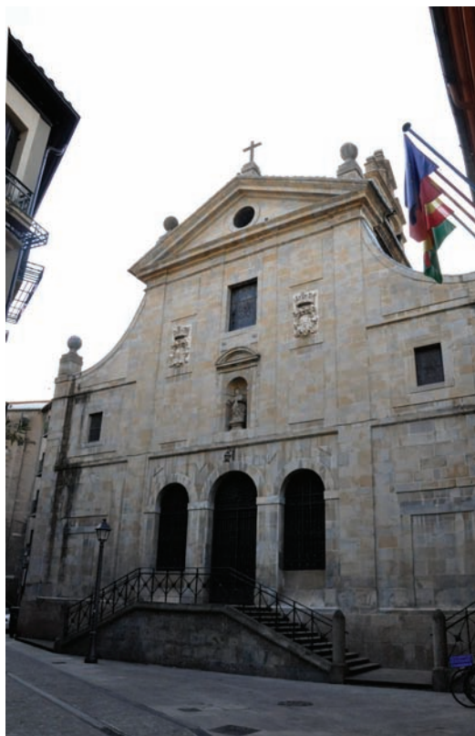
Imagen 4. Fachada de la iglesia del convento de carmelitas descalzos de Santa Ana de Pamplona, ejecutada por Pedro de Azpíroz (1667-1672).
